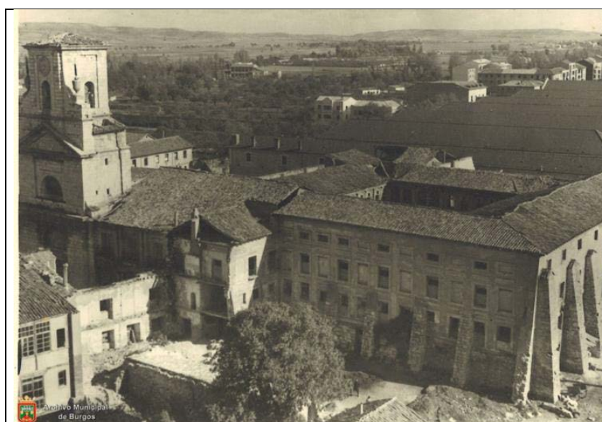
FOTOGRAFÍA DEL ALZADO OESTE DURANTE LAS DEMOLICIONES DE HACIA 1945
